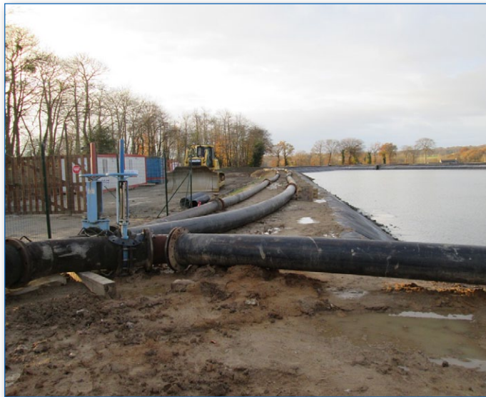
La lagune 1 de décantation et l'accès au site
